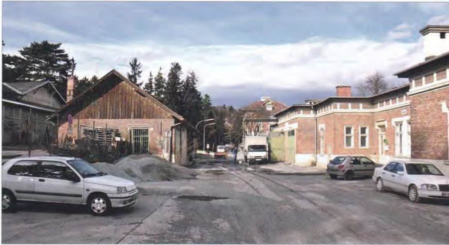
Das Wirtschaftsareal im Juni 2011: Die Schmiede (Mitte links), der ehem. Pferde­stall (links außen) und das Garagengebäude (rechts) mussten inzwischen den VAMED-Bauten weichen.
