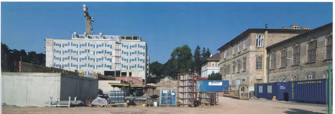
Neubauten, vom Bundesdenkmalamt bewilligt, im Wirtschaftsbereich (VAMED-Baustelle im Juli 2012).
