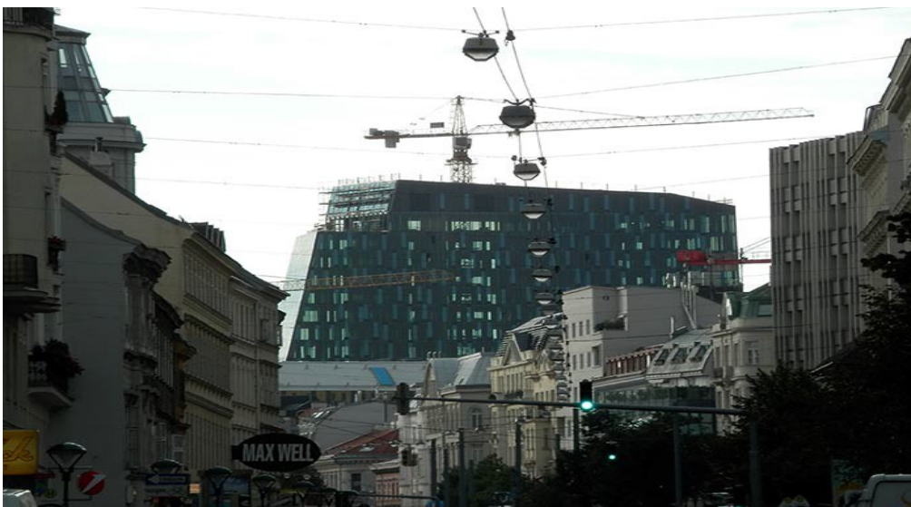
Hochhausprojekt Wien Mitte: Der Blick von der Landstraße, Standort Rochus Markt Richtung Innenstadt. Dunkle Baumassen verstellen den Blick.
