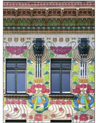
Detail der Fassade des „Majolikahauses“, Linke Wienzeile Nr. 40, Wien-Mariahilf.
