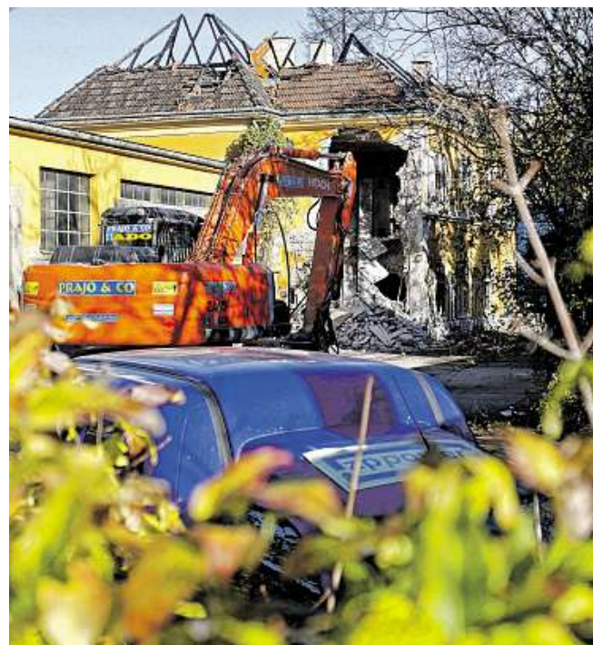
Das Biedermeierhaus brannte zwei Mal – nun wird es abgerissen
