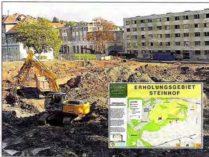
Bagger statt Erholungsgebiet: Am Steinhof wird bereits gegraben
