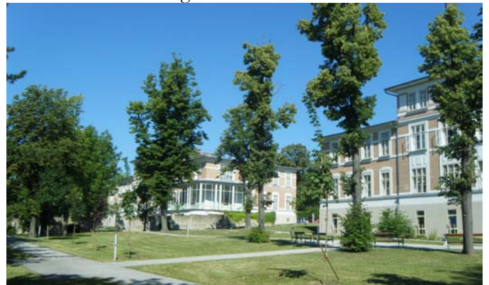
Pavillons im Westteil der Anlage
