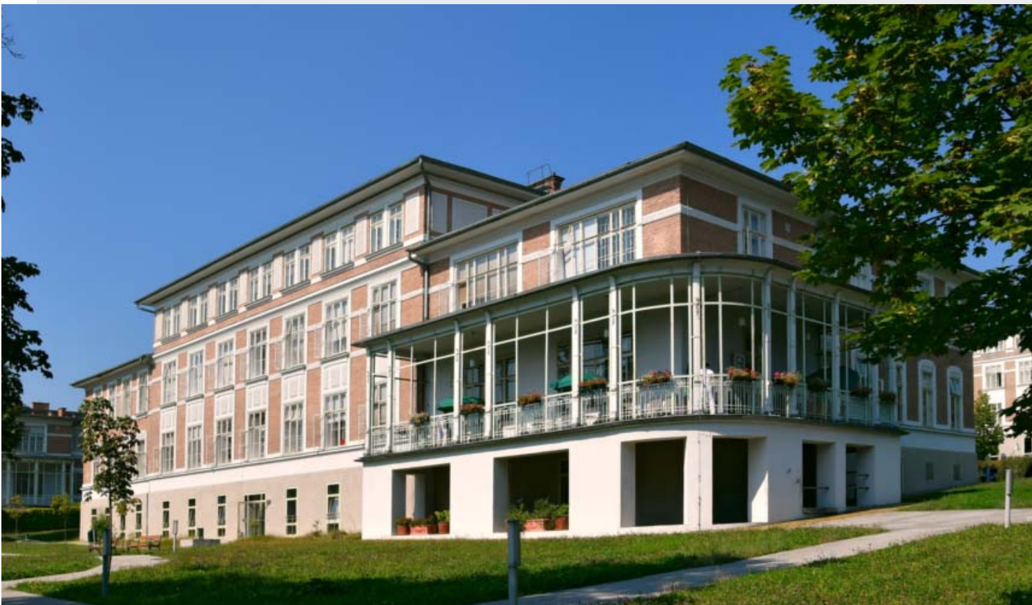
Abb. 5: Otto-Wagner-Pavillon am Steinhof-Areal: In rund 17 dieser Pavillons könnte nach 2023 eine Privatuniversität des Währungsspekulanten George Soros einziehen. Ob die dafür notwendigen Umbauten denkmalschutzverträglich sind, hat bisher niemand untersucht. Das Bundesdenkmalamt wurde von der Stadt Wien während der Vertragsverhandlungen weder konsultiert, noch informiert.
