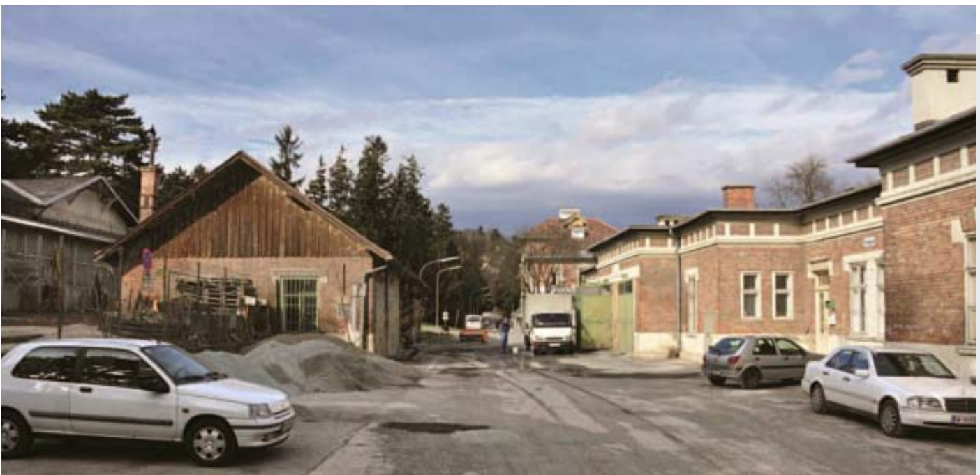
Abb. 1: Das Wirtschaftsareal im Juni 2011: Die Schmiede (Mitte links), der ehemalige Pferdestall (links außen) und das Garagengebäude (rechts) mussten nach Aufhebung des Denkmalschutzes inzwischen den VAMED-Bauten weichen. (Hist. Zustand dokumentiert v. Gerhard Hadinger)
