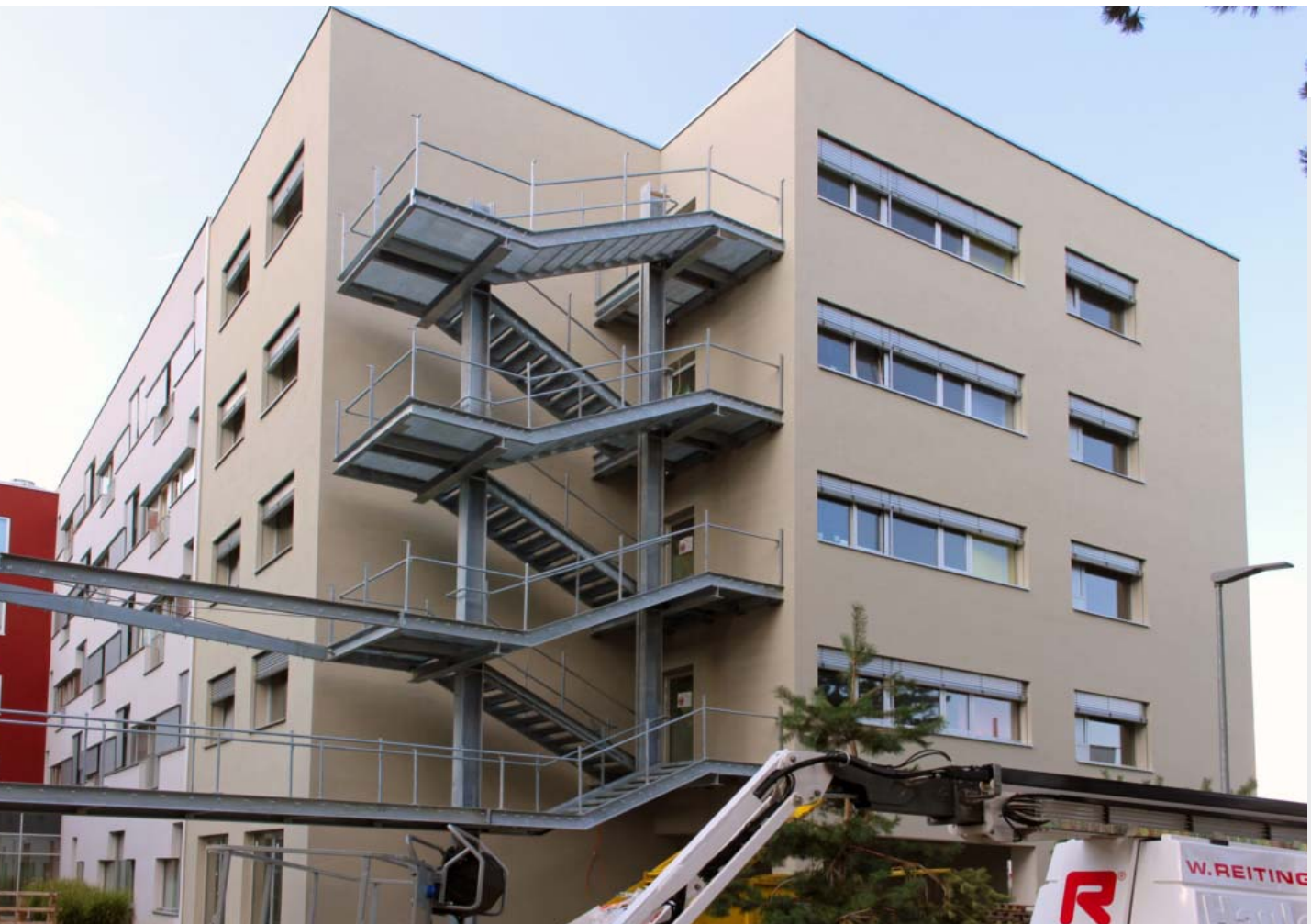
Abb. 2: Derselbe Bereich wie im Bild auf der vorigen Seite (Abb. 1, Seite 3) im August 2016. Ein VAMED-Komplex mit Außen-Fluchttreppen im Otto-Wagner-Areal.
