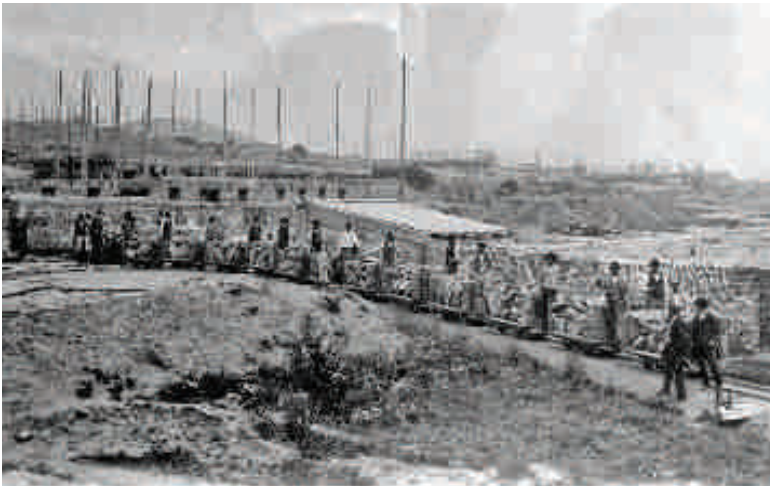
- ebenso der Abtransport des Aushubmaterials
