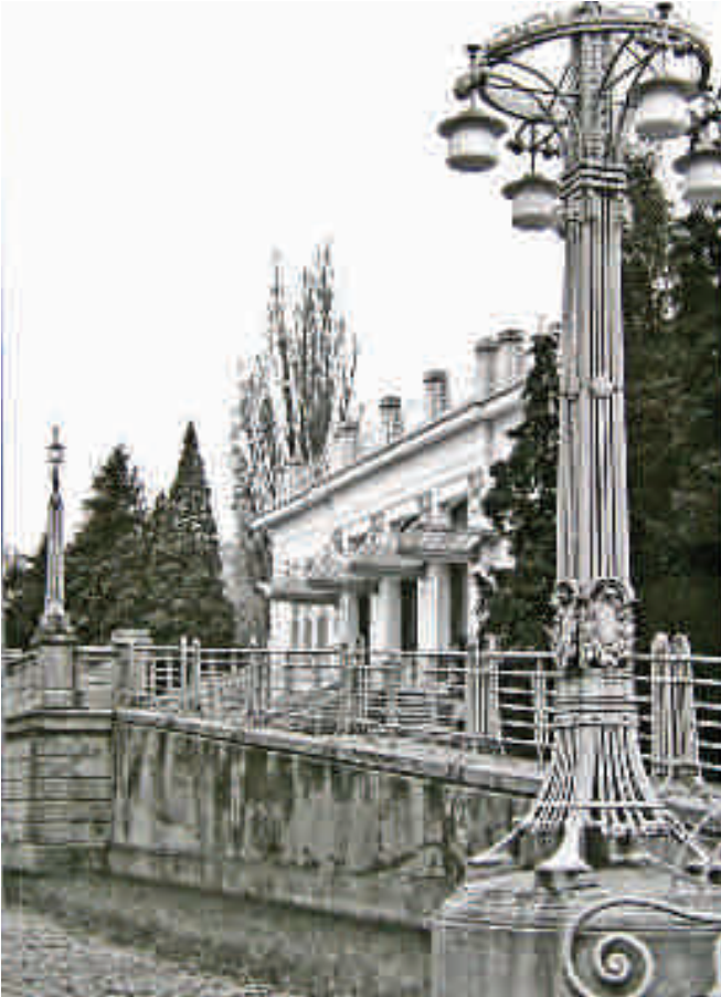
Festlich ausgestattete Aufgangsrampe zum Eingang des Theaters
