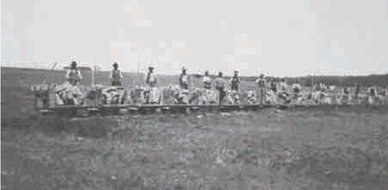
Materialbahn mit Bremsern auf den Steinhofgründen
