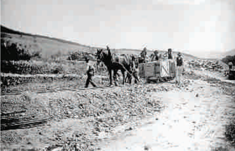
Bauarbeiten wurden durch Schienen und Pferdewagen erleichtert
