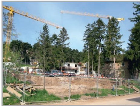
Direkt neben der ehemaligen Fleischerei werden sechs Wohnblöcke errichtet.
